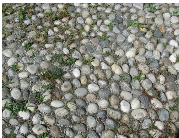
Pavimentazione in selciato (in alto) e in acciottolato
