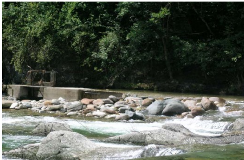
Valchiusella – Comune di Vistrorio: particolare paratoia di scarico a valle traversa di presa
