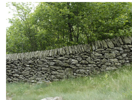
Coronamento superiore in lastre posate a coltello
