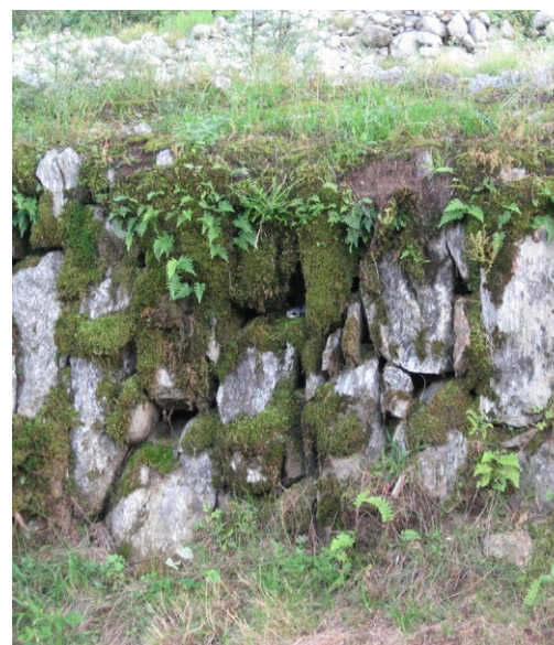
Particolari di murature da spietramento di pregevole e sapiente fattura.
