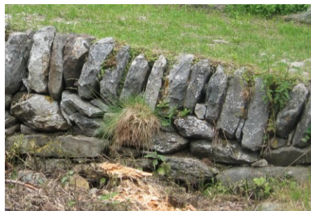
sopra MURO A MONTE Talvolta i muri inglobano o sostengono massi di grandi dimensioni
