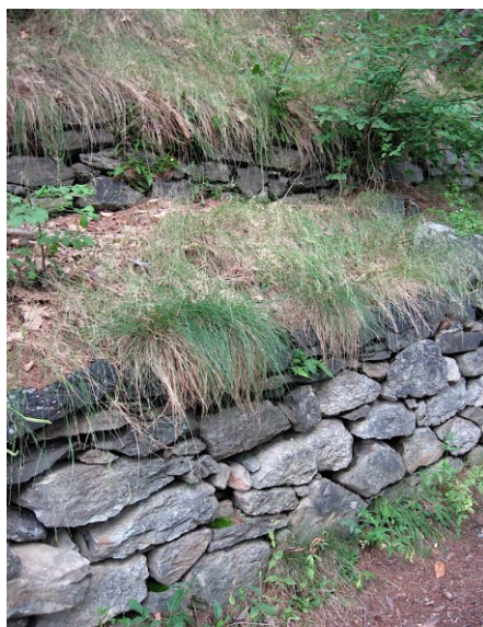
MURO IN PIETRA A SECCO Per ridurre le altezze, viene utilizzata la soluzione di due muretti
