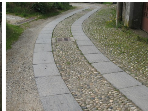
Acciottolato con lastre disposte su due corsi
