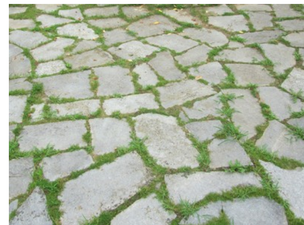
Pavimentazione in lastricato con giunti inerbiti
