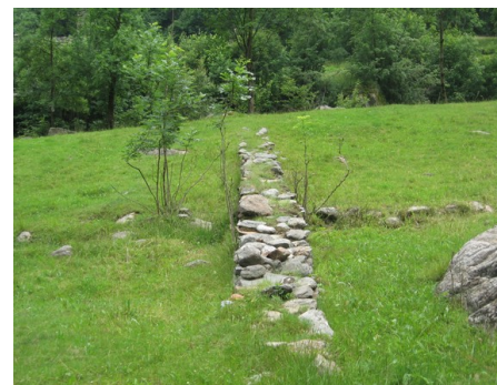
Muro a secco di delimitazione delle proprietà
