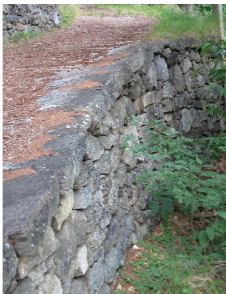
MURO DI SOSTEGNO A VALLE Con coronamento in lastre di pietra posate di piatto
